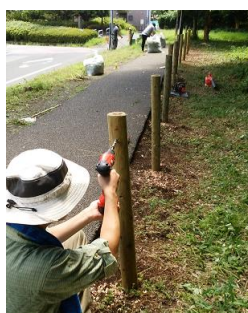
杭にドリルで穴開け
