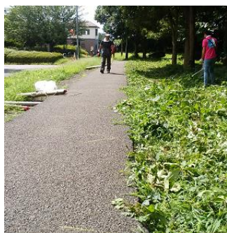
古い杭を抜いて
