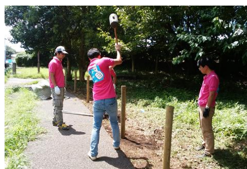
何本も杭を打ち込んでいきます
